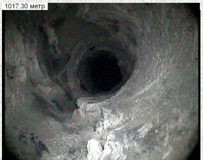
Рис.4 Отложения на колонне перед забоем
