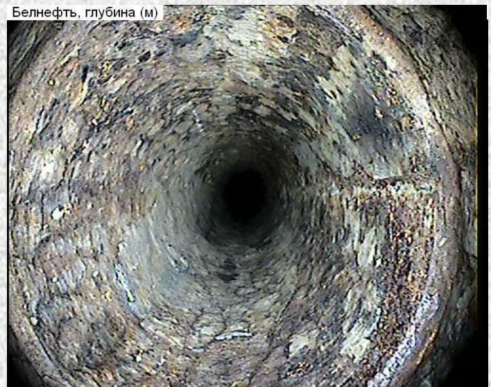
Рис.10 Видеоинспекция стенок колонны
