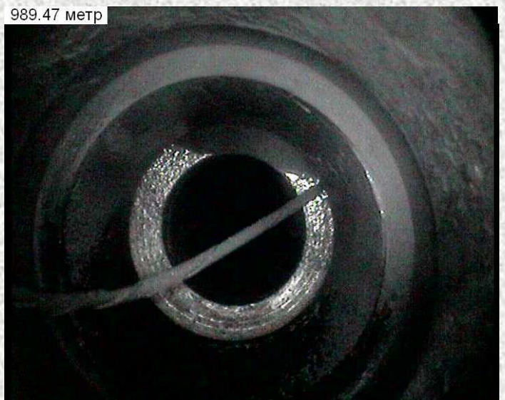
Рис.12 Фрагмент кабеля в НКТ
